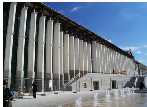
La halle Honnorat, extension de la gare SNCF Saint-Charles de Marseille: 64 piliers précontraints en pierre de Lens et de Mont Caume, conçus pour résister à des efforts en flexion.
